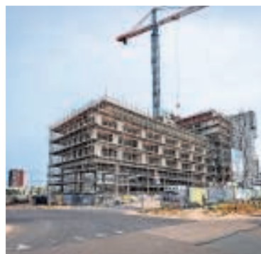
▲ Appartementen in aanbouw in Nesselande. FOTO JAN KOK
